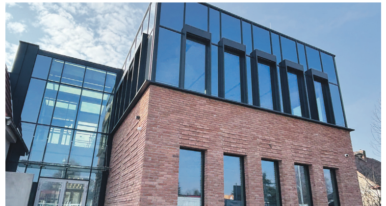
Budowa biblioteki w Długołęce zbliża się do finišu
