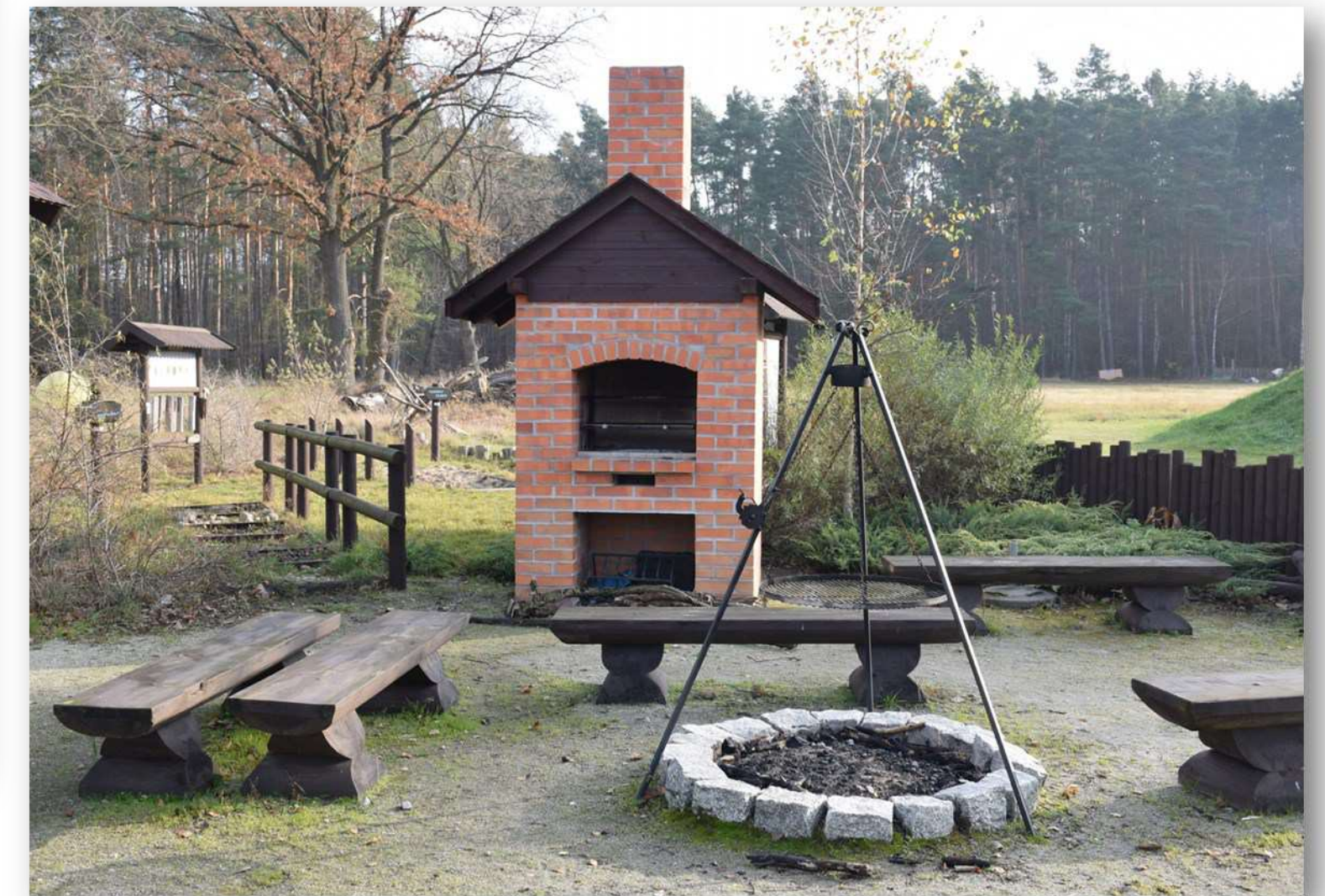
Stworzenie miejsca rekreacji poprzez budowę grilla w miejscowości Grochowa
