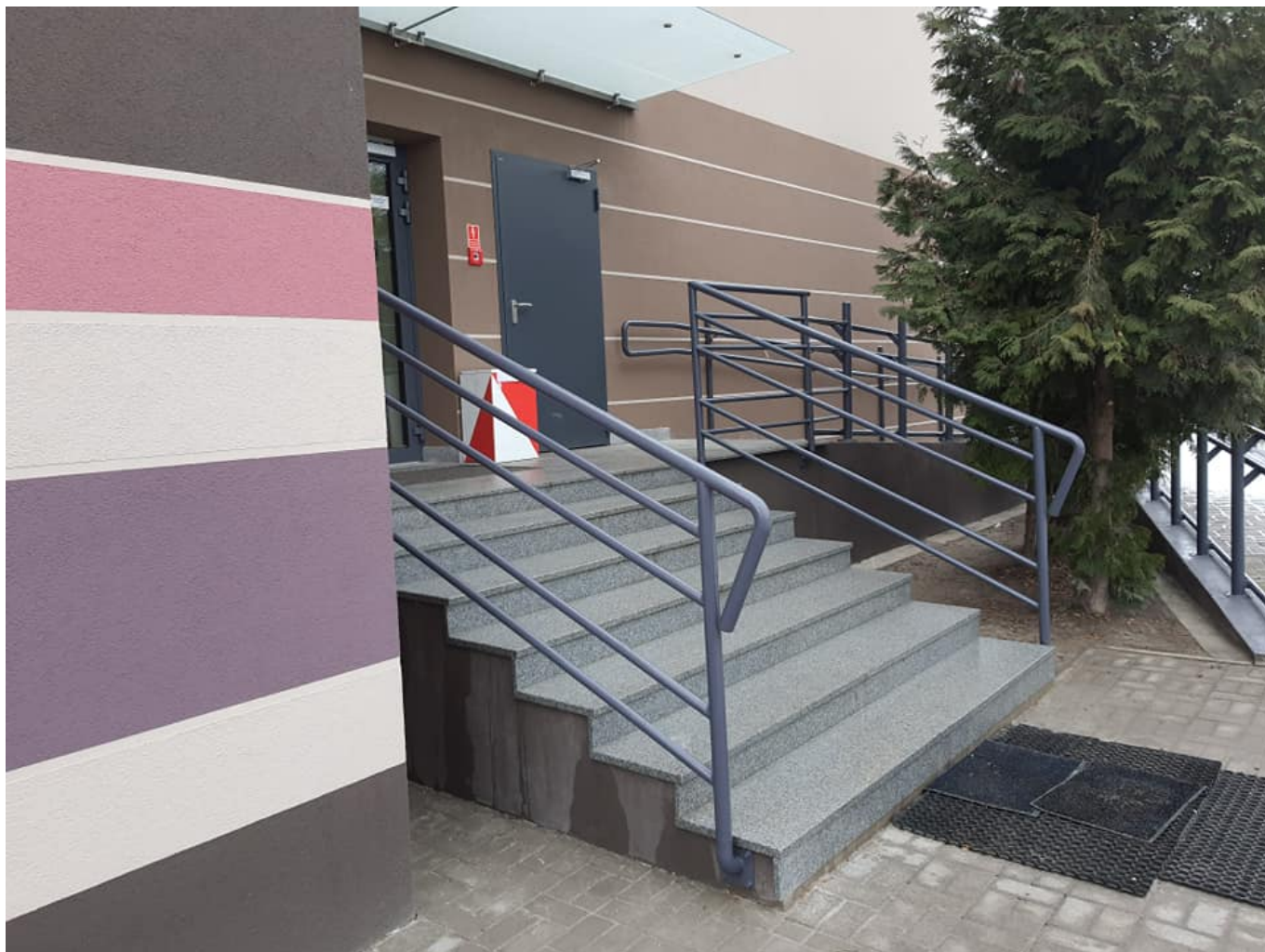
Nowy budynek GOK
